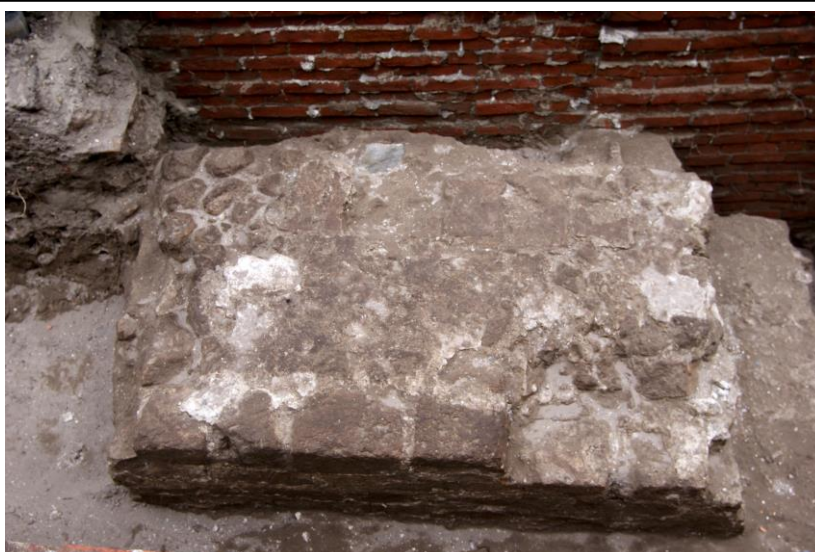
Een stuk fundering van de middeleeuwse kruiskerk. De grote stenen zijn tufstenen van de Romaanse kerk die daarvoor gestaan heeft. In het pad ter tussen nr.50 en nr 9.
